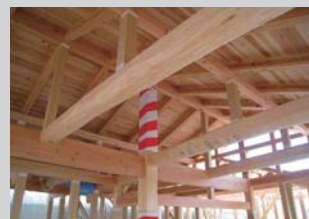
真ん中の紅白の布で覆われているのが、大黒柱（写真3点施工中写真）
