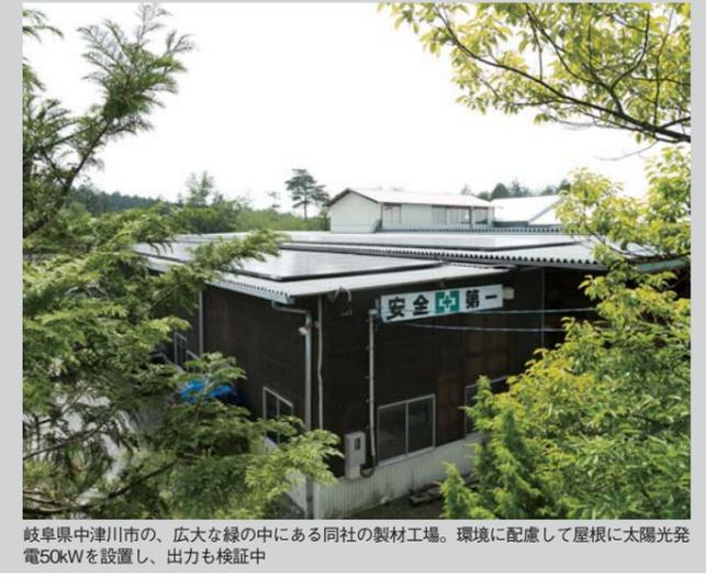
岐阜県中津川市の、広大な緑の中にある同社の製材工場。環境に配慮して屋根に太陽光発電50kWを設置し、出力も検証中
