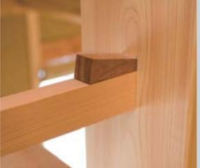
細かいところまで大工の技が光る同社の住まい。くさびはまるでアートのような(施工例)
