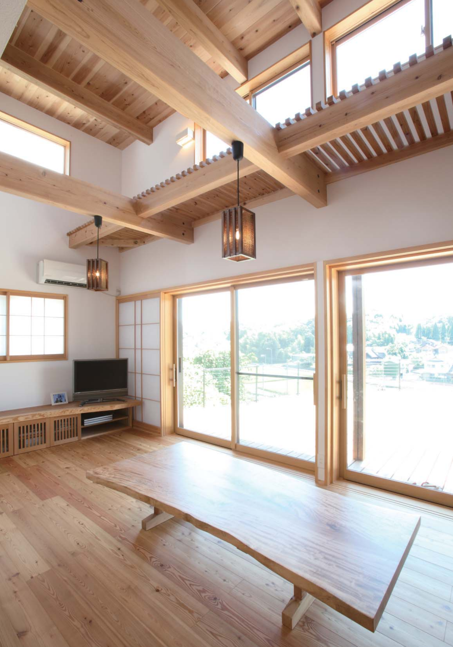
太い桁や天井の杉の羽目板が印象的なリビングは、高い位置にある窓を開閉するためのキャットウォークが、空間に遊びゴコロをプラス。リビングから小屋裏に飲み物を運ぶ滑車も作る予定で、大人も子どもも楽しめる開放的な住まいだ。テレビ台の一枚板や玄関の式台、トイレのカウンター、和室の柱などは工場まで使用する木材を選びに行き、愛着のわく住まいとなった
