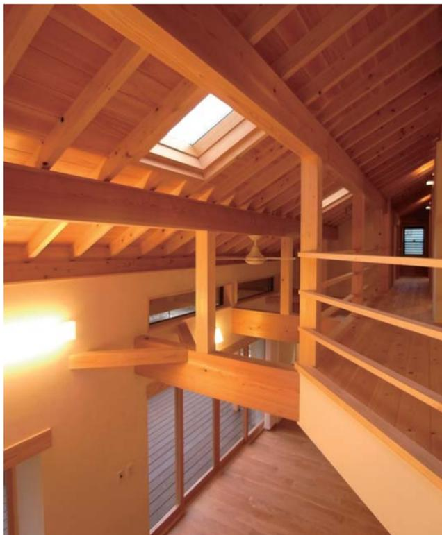
「構造が見えていた方が安心する」というAさんの希望で、屋根裏はあえて構造材が見えるようにし、光を取り込むトップライトや空気の淀みを浄化するサーキュレーターも設置した
